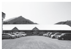
屋根の老朽化が進む久慈市屋内ゲートボール場
