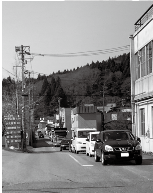
右折レーンの設置工事で渋滞緩和が期待される長内橋付近の市道小久慈線
