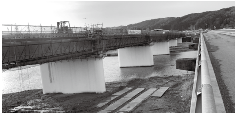
急ピッチで工事が進む湊橋
