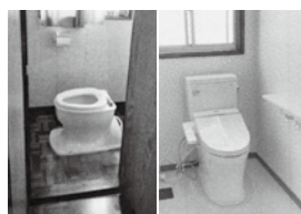
トイレのリフォーム写真。工事前(左)と完成後(右)
