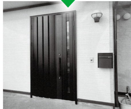
住宅リフォームの一例（玄関の改修）
