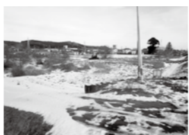
新井田地区の雨水排水ポンプ場建設予定地
