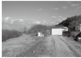
大成橋上流の堤防未整備区間
