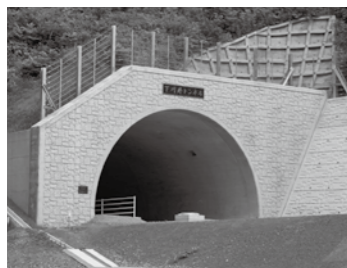
開通が待たれる下川井トンネル
