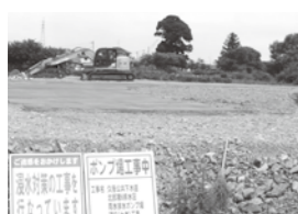
雨水排水ポンプ場の建設地(新井田地区)
