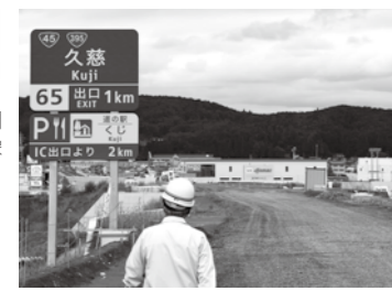
全線開通による経済効果が期待される三陸沿岸道路の工事状況（長内町）
