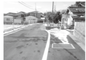
5年前から工事がストップしている山岸線(源道)
