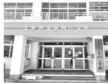
温暖化の影響で小中学校のエアコン整備が求められている
