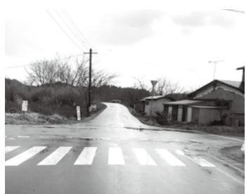
用地取得が進まず、歩道整備が止まっている通学橋付近
