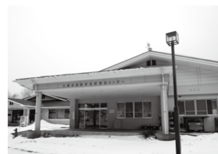
ボイラー等を改修する山形デサイビスセンター(愛山荘)
