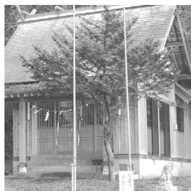
ハチの巣などを狙い民地付近でもクマによる被害が増加中。注意喚起をしている大川目町の神明宮
