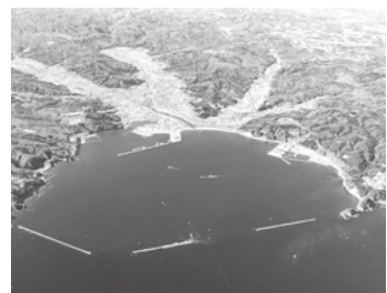
整備の進む久慈港湾口防波堤 (写真：釜石港湾事務所提供)
