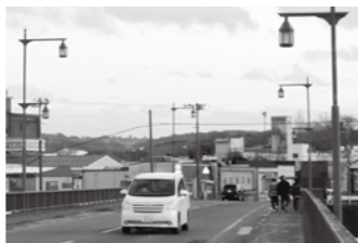
中心市街地と住宅地を結ぶ中の橋
