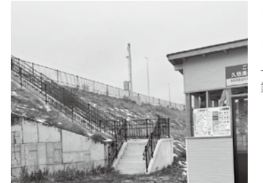
三陸沿岸道路への避難階段(新井田地区)垂直避難も要検討！
