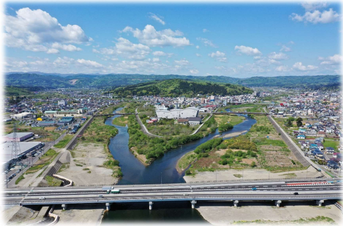
三陸沿岸道路（久慈大橋、久慈 IC 付近）と側道橋化された国道 45 号、後方は久慈市街地
